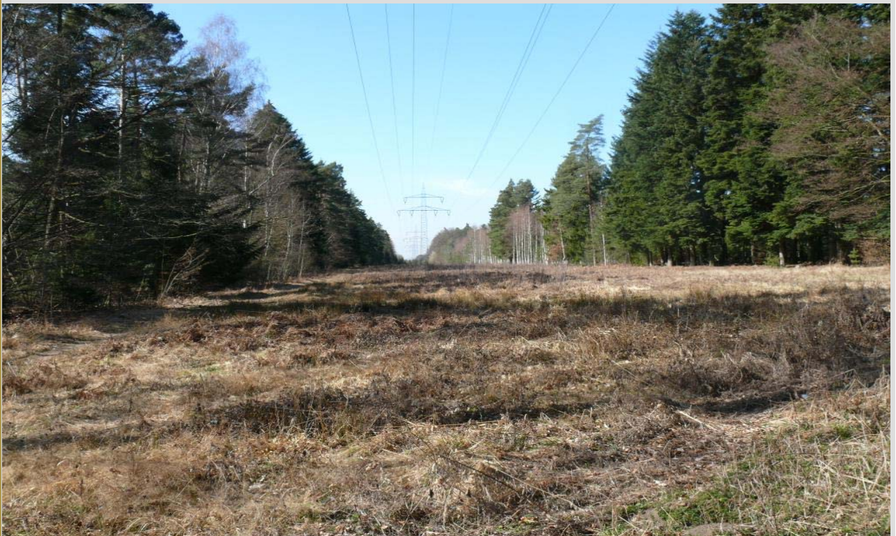
Blick nach Südwesten
